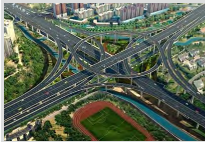
杭州市彩虹快速路（滨江段） 项目测绘
