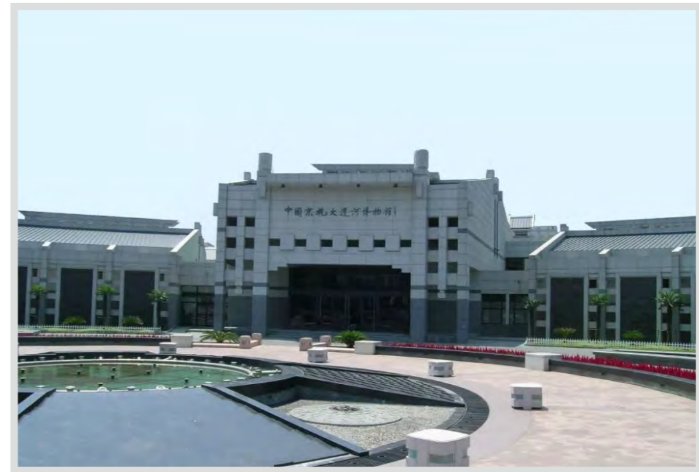
运河广场、博物馆及地下商城桩基工程
