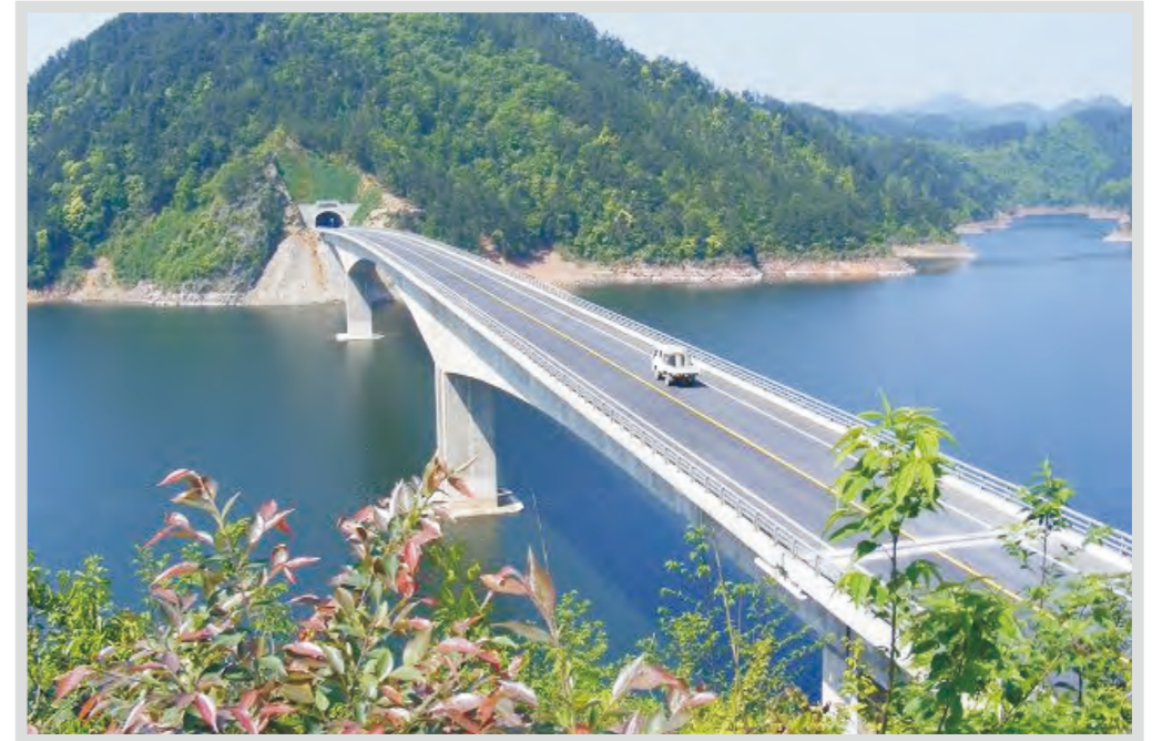
杭州市淳安县小金山特大桥
