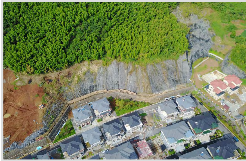
青山湖库区板桥镇如龙安置小区边坡治理项目
