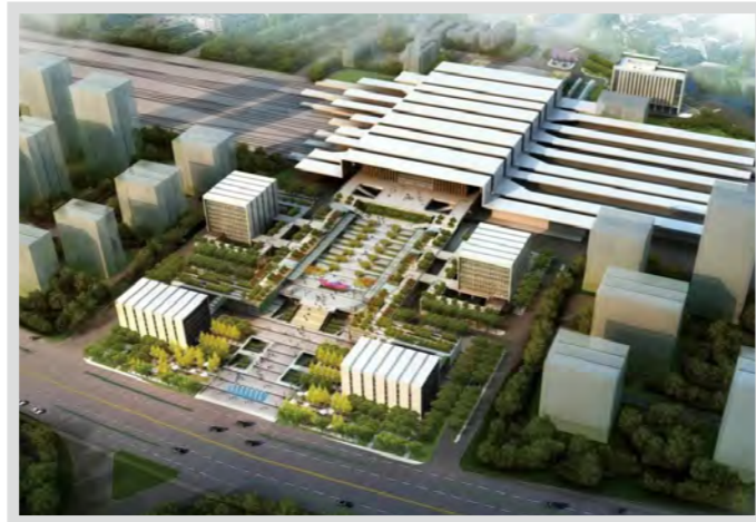
杭州南站综合交通枢纽东西广场工程
