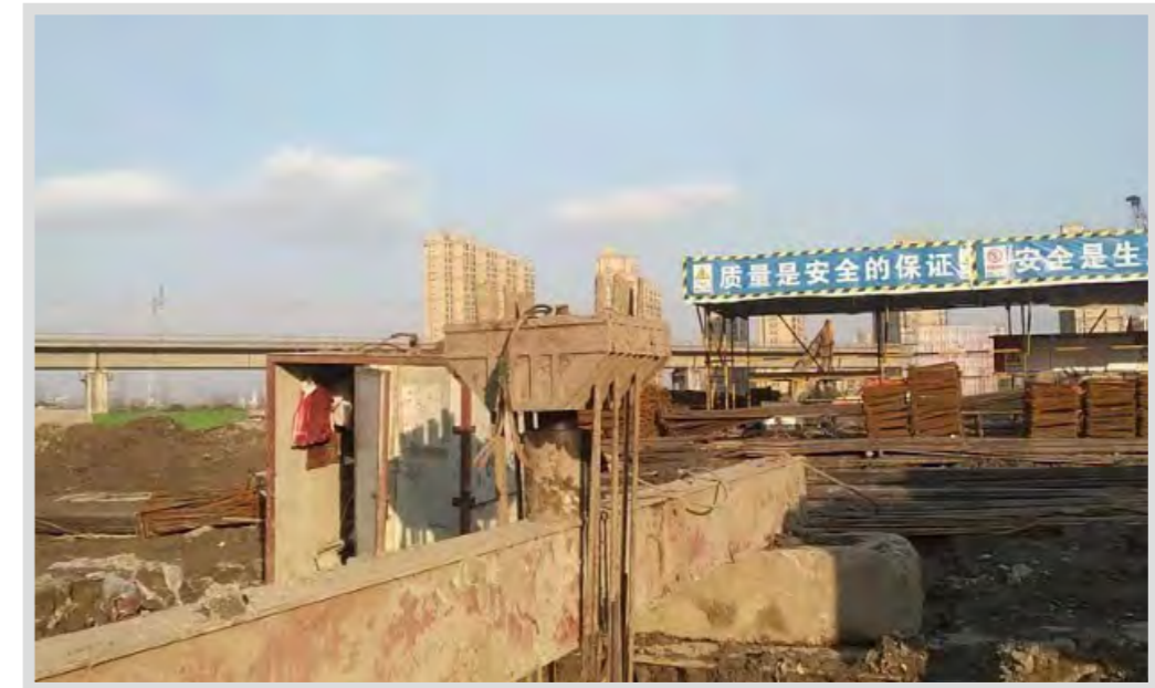
桩基检测单桩竖向抗拔静载试验现场
