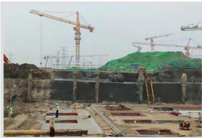
2022年第19届亚运会媒体村 地块基坑支护
