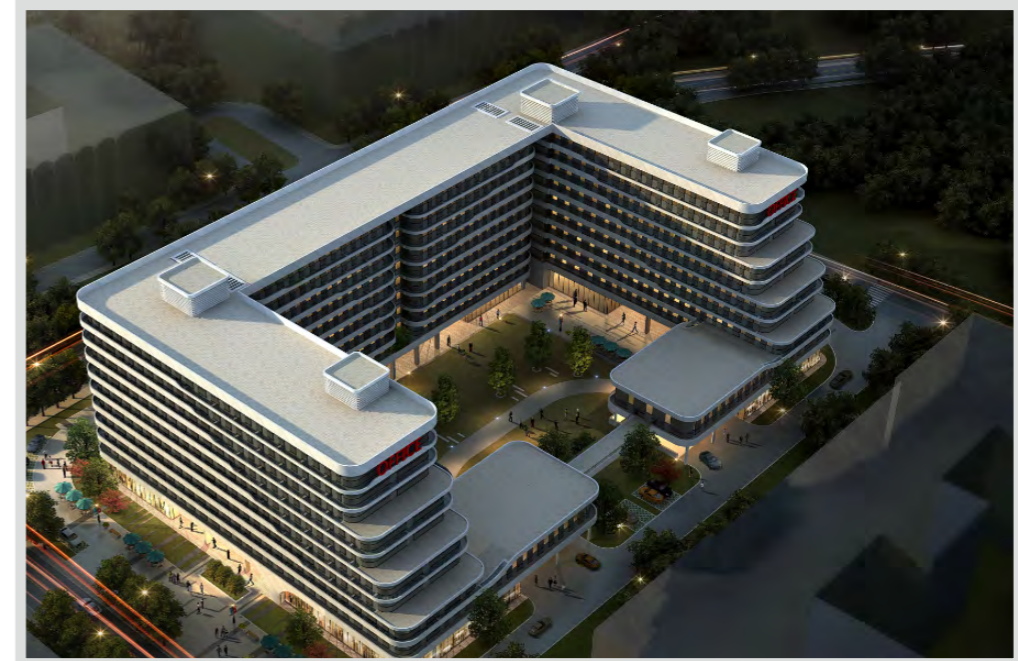
蓝天园林综合楼项目桩基及围护工程
