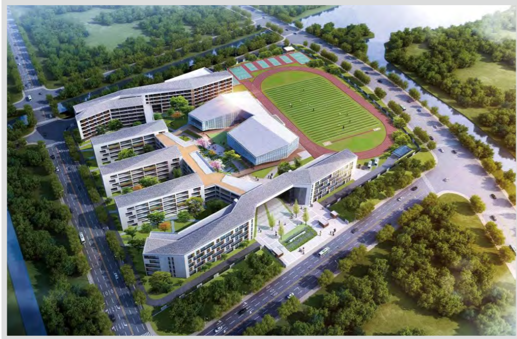
余杭区中泰中学迁建项目桩基工程
