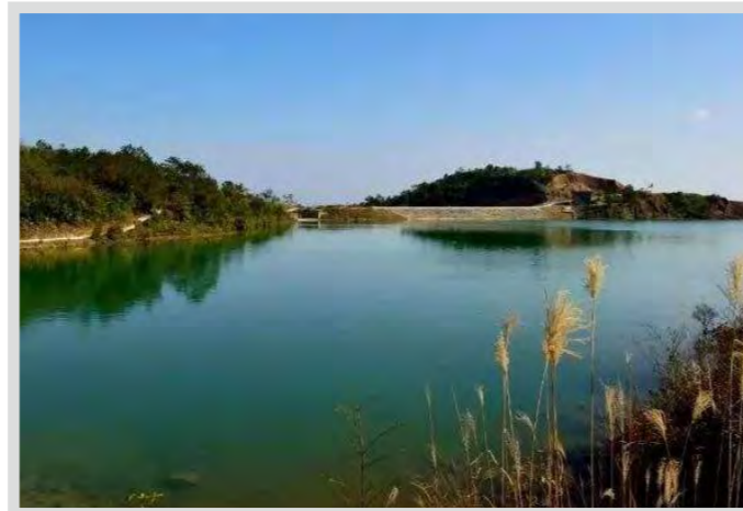
建德2018-2019年度中央财政小型 农田水利项目县山塘安全性鉴定地勘
