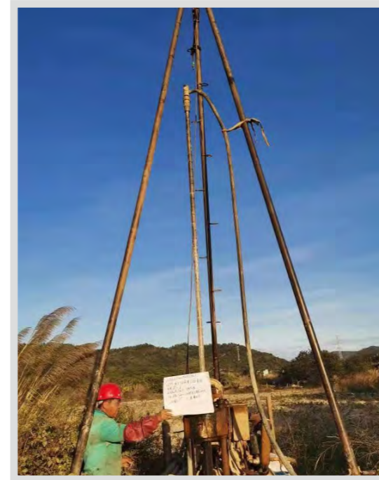
广州惠州LNG接收站外输管道工程
