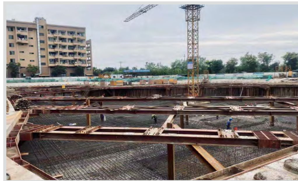
中策橡胶（安吉）有限公司宿舍楼基坑监测项目
