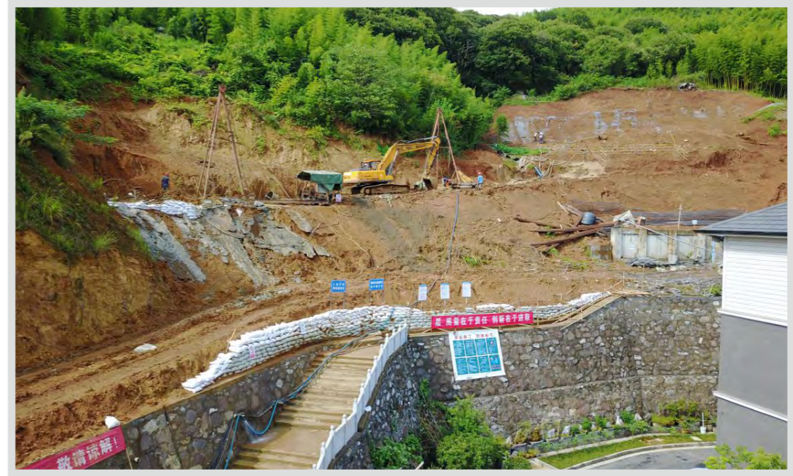
青山湖库区板桥镇如龙安置小区边坡治理项目
