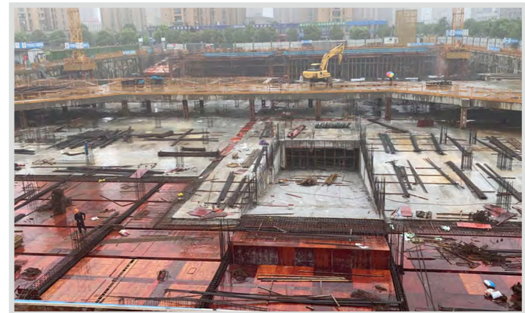
吉鸿股份经济合作社商业综合用房（20）号地块基坑监测
