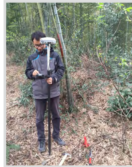
110KV枫姜线1680线迁改工程测量
