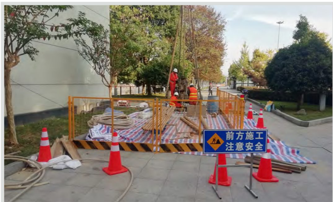
杭州未来科技城菜鸟北侧道路工程
