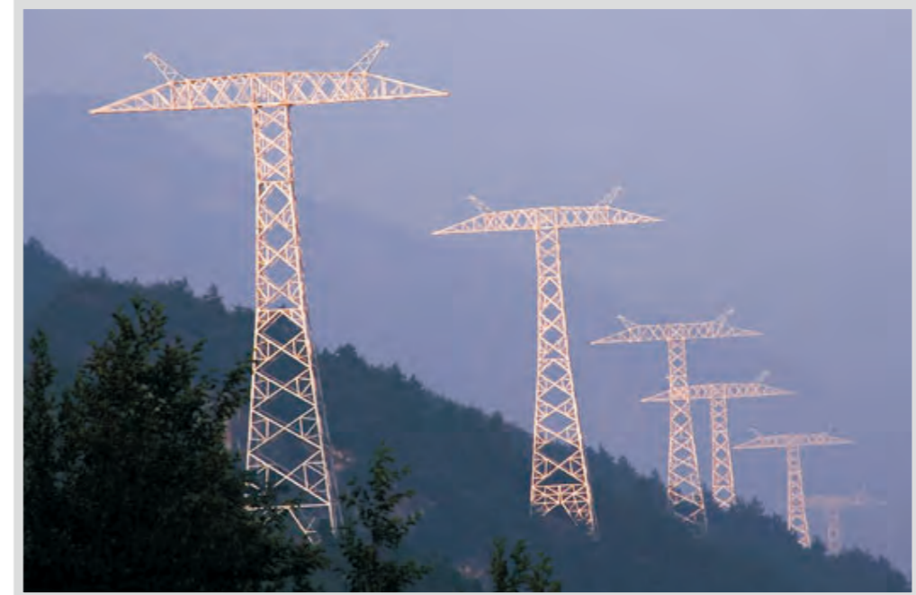
淮南-浙北-上海1000千伏同塔双向特高压交流输电工程
