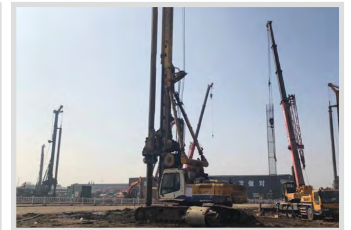
三墩单元XH0306-M1-39地块新制 造业项目----桩基工程
