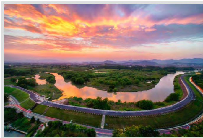
茗溪堤防加固
