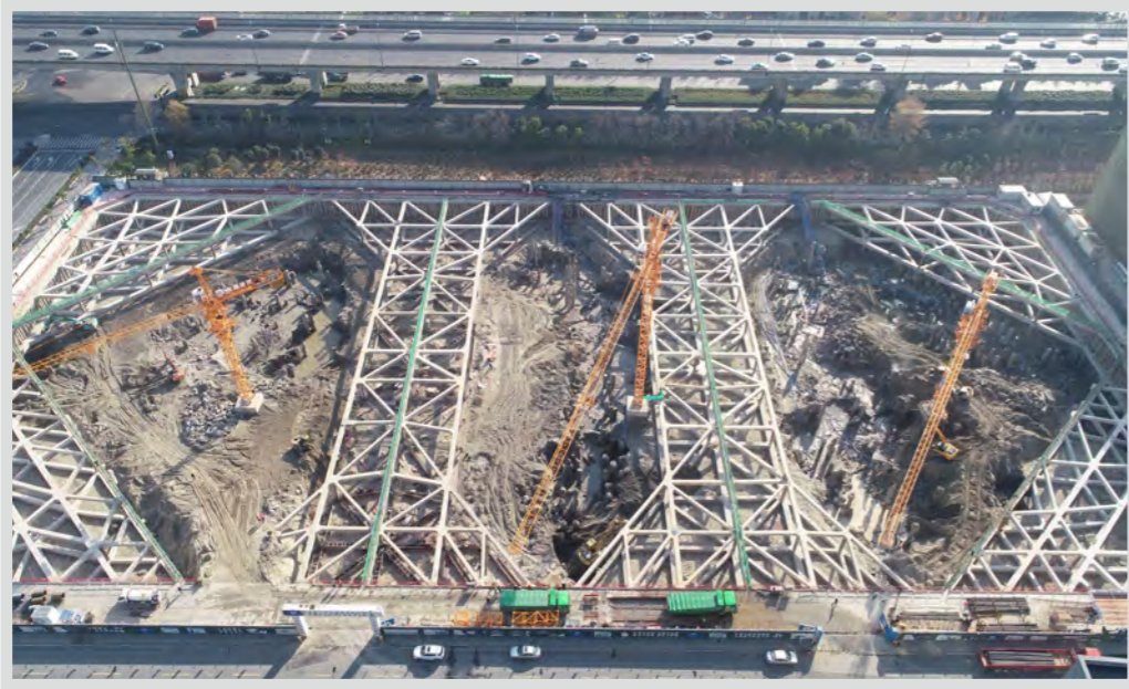
杭州吉行总部大楼基坑监测项目
