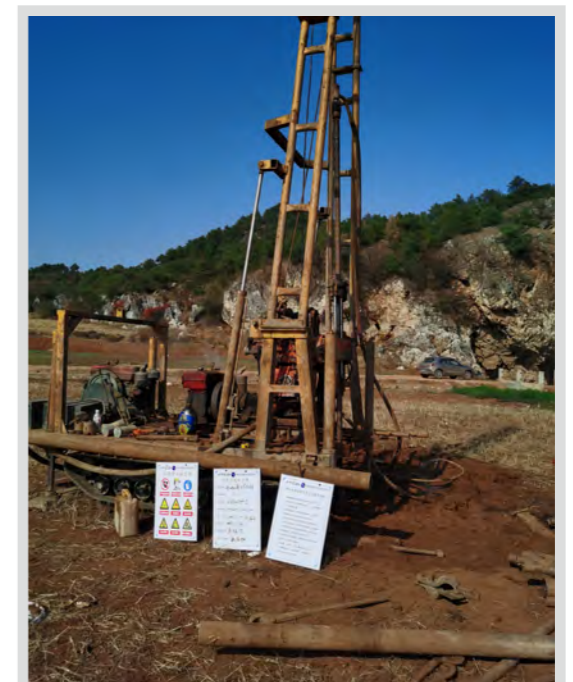
仙居至庆元公路龙泉至道太段工程勘察
