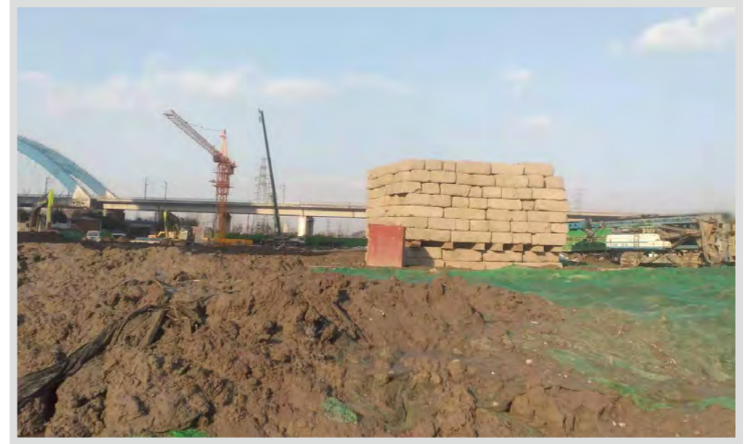
桩基检测单桩竖向抗压静载试验现场
