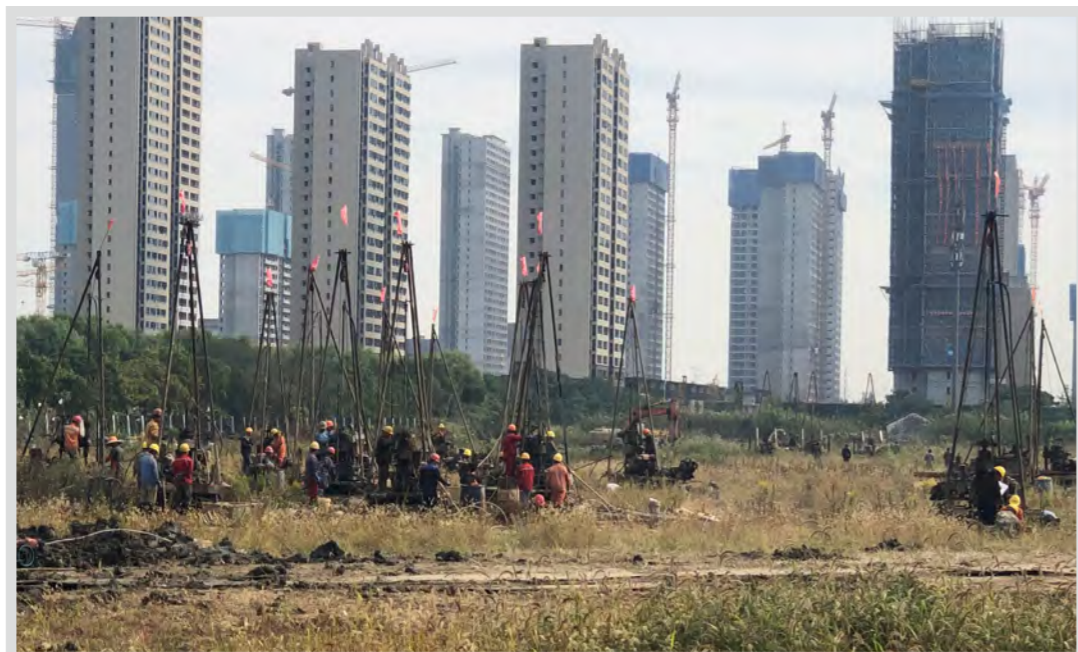
湖州市中医院迁建项目勘察工程（一桩一探）
