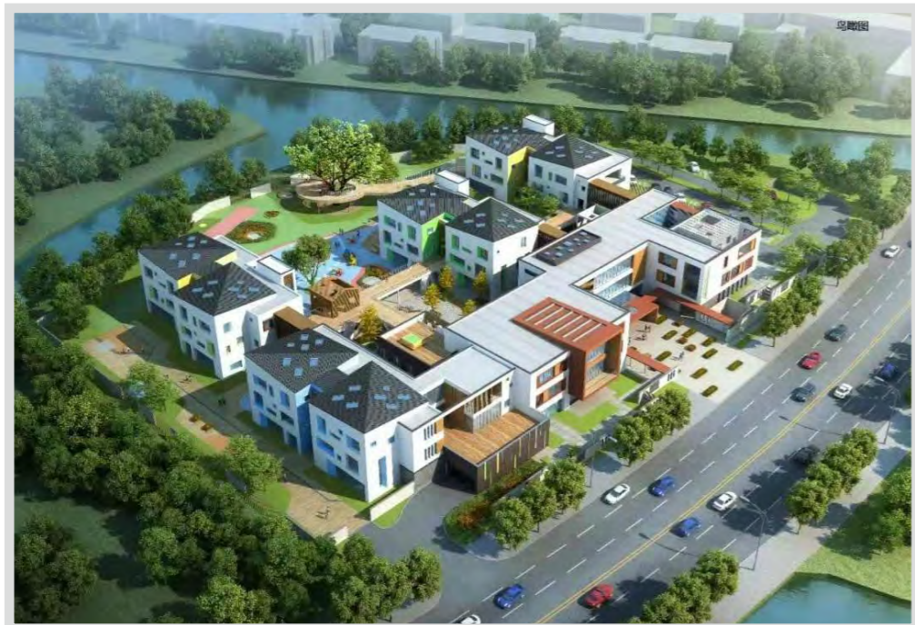
闲林中心幼儿园万景分园项目桩基
