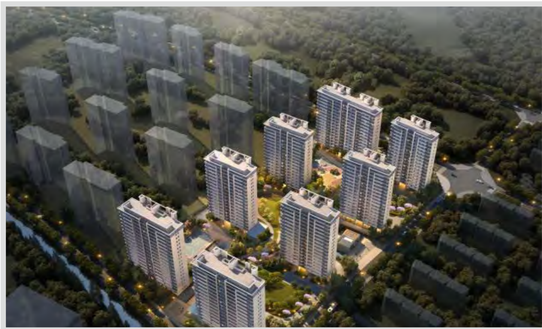
黄岩区杜家村安置房工程
