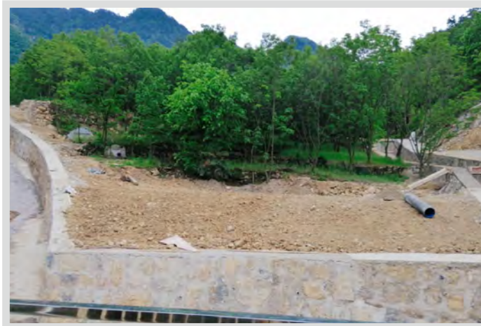
临安区岛石镇桥川村汪庄坞泥石流地质灾害治理工程
