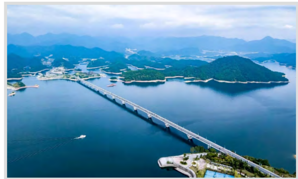
淳安县环湖公路上江埠特大桥勘察项目
