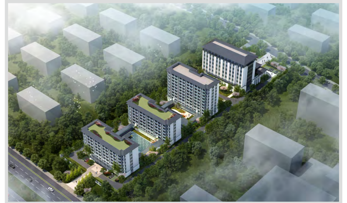
黄岩区医疗中心康养工程（勘察）
